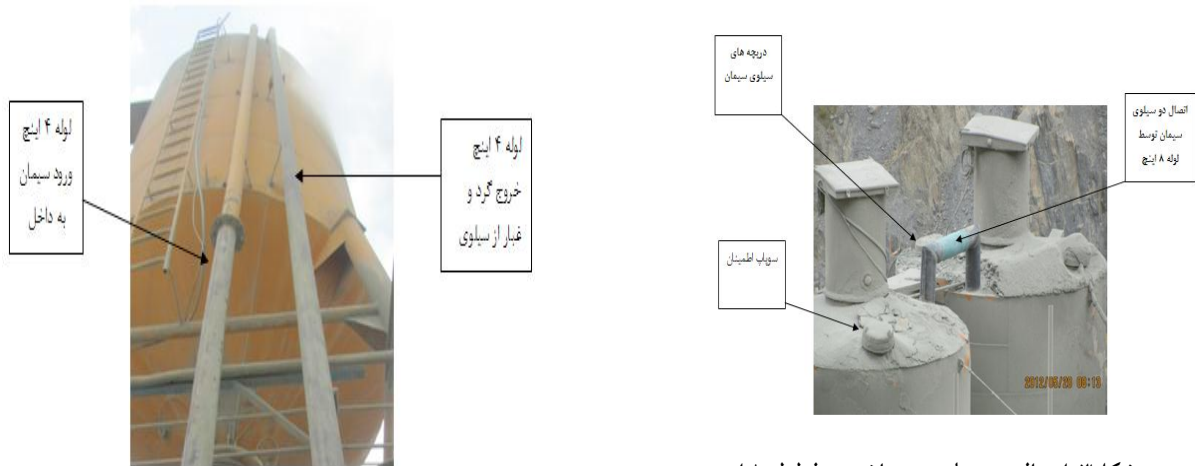
شکل ۳: اتصال دو سیلوی سیمان توسط لوله ۸ اینچ
