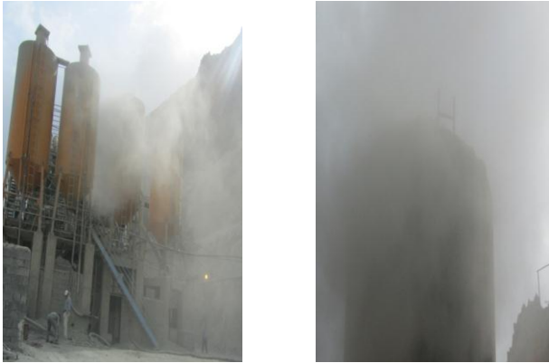
شکل ۱: محیط بچینگ ها به هنگام شارژ سیمان و تولید بتن قبل از اجرای روش کنترل
