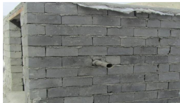
شکل ۵: اتاقک رسوب دهنده و محل ورود گرد و غبار
